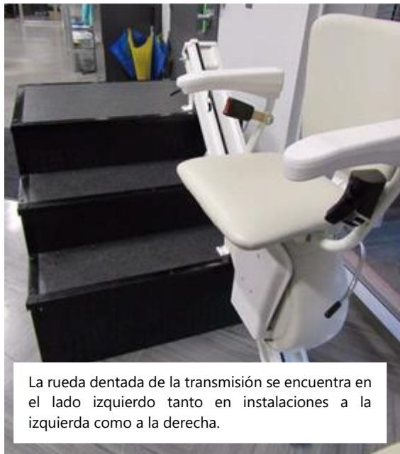
Fig. 5.2 - Dispositivo para diestros instalado en el lado derecho, visto desde el rellano inferior
